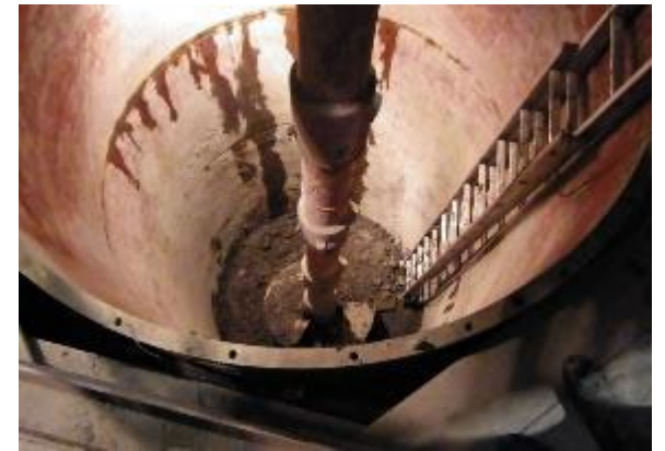
ピット掘削の様子
