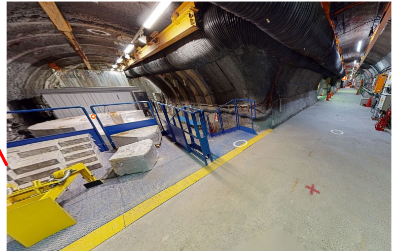
坑道掘削の影響調査に関する調査技術開発でトモグラフィ調査を実施した坑道付近の写真
