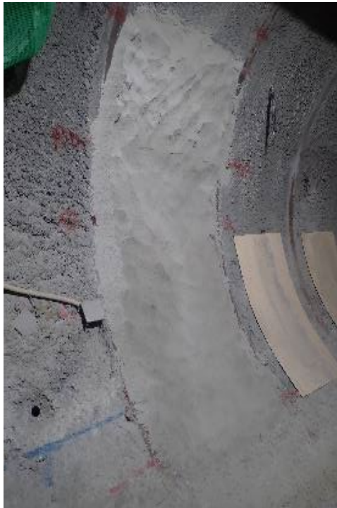
吹付け施工後の様子
